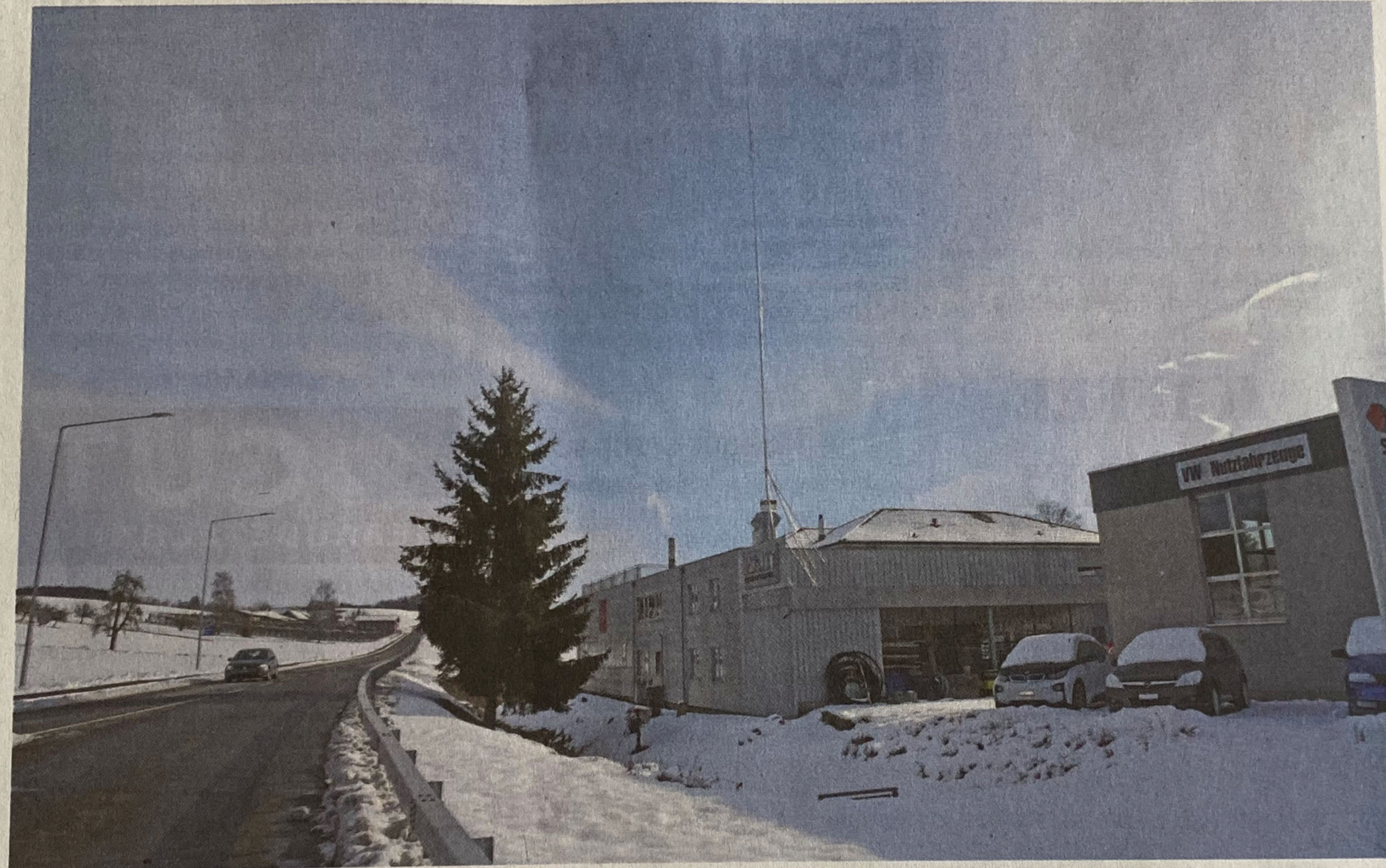
Im Gebiet Ebersmoos möchte der Telekommunikationsanbieter Swisscom eine 5G-Antenne erstellen.
